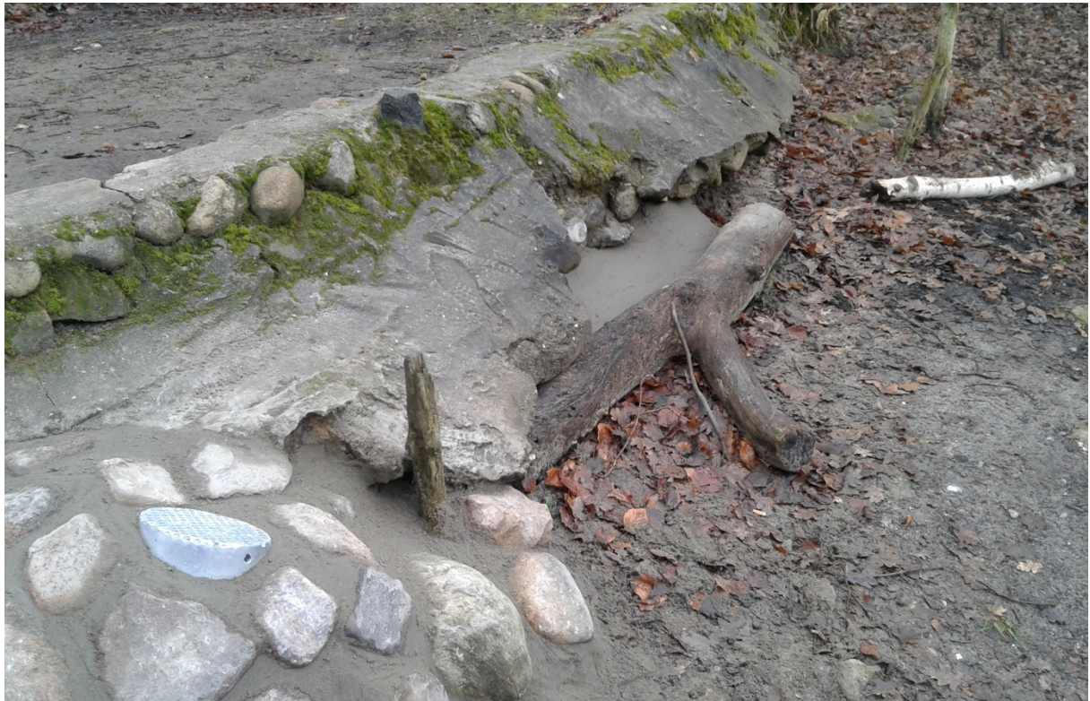
Durchlass Düstere Teiche Reparatur Notüberlauf im Dez. 2016
