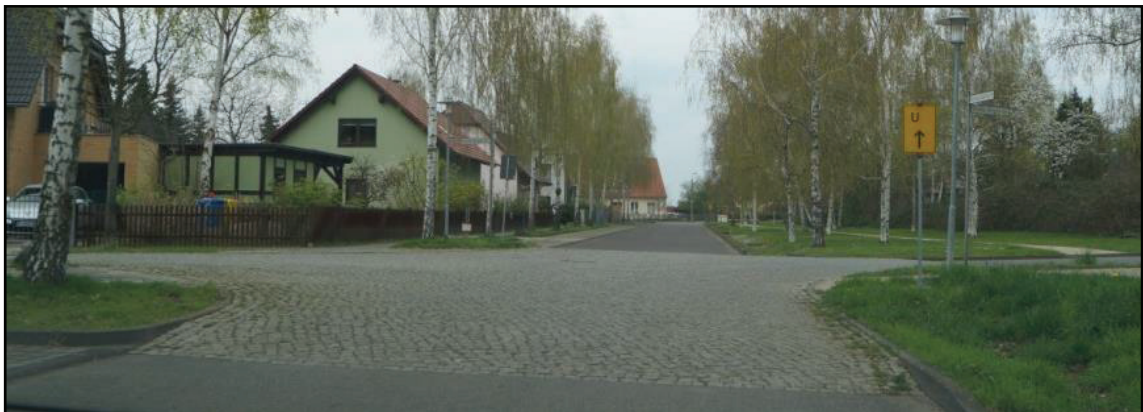
Abb. 43 Beispiel Knotenpunktaufpflasterung (Hermann-Mächtigt-Straße)
