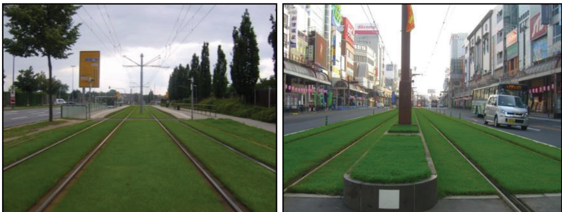
Abb. 49 Beispiele für hochliegendes Rasengleis Dresden, Japan (Quelle: Wolfgang Lambacher)
