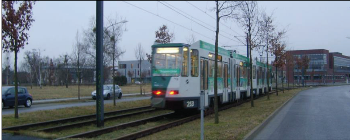
Abb. 50 Beispiel tief liegendes Rasengleis Potsdam
