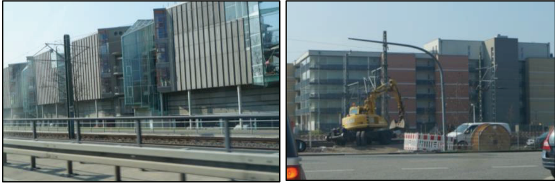
Abb. 46 Beispiel Lärmschutzbebauung Hans-Marchwitza-Ring bzw. Zum Wasserturm
