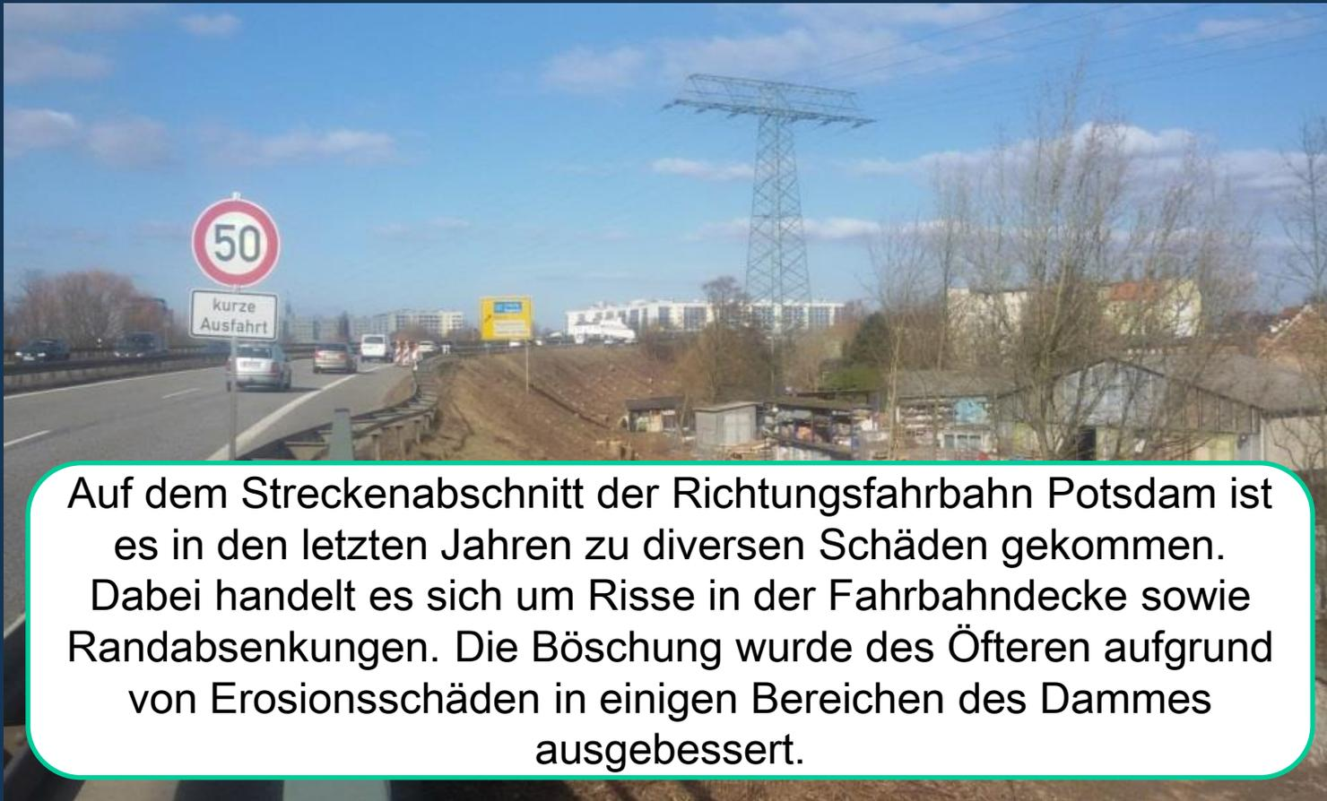
Auf dem Streckenabschnitt der Richtungsfahrbahn Potsdam ist es in den letzten Jahren zu diversen Schäden gekommen. Dabei handelt es sich um Risse in der Fahrbahndecke sowie Randabsenkungen. Die Böschung wurde des Öfteren aufgrund von Erosionsschäden in einigen Bereichen des Dammes ausgebessert.
