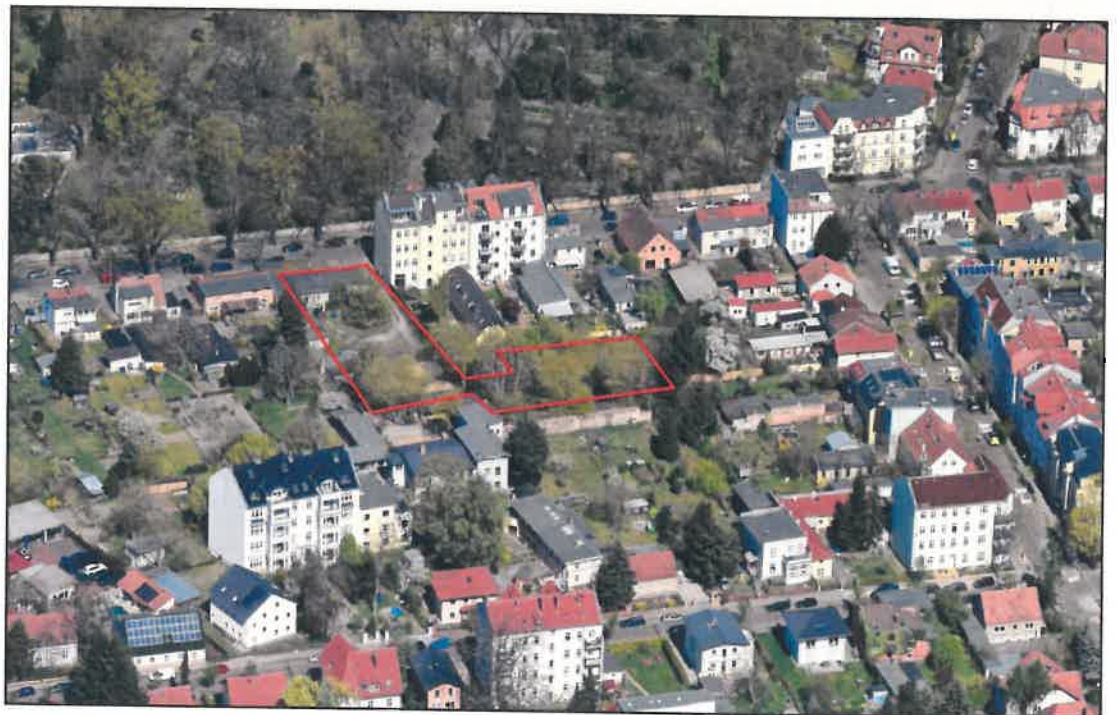
Luftbildaufnahmen April 2016, ungefähre Lage des Grundstücks rot markiert
