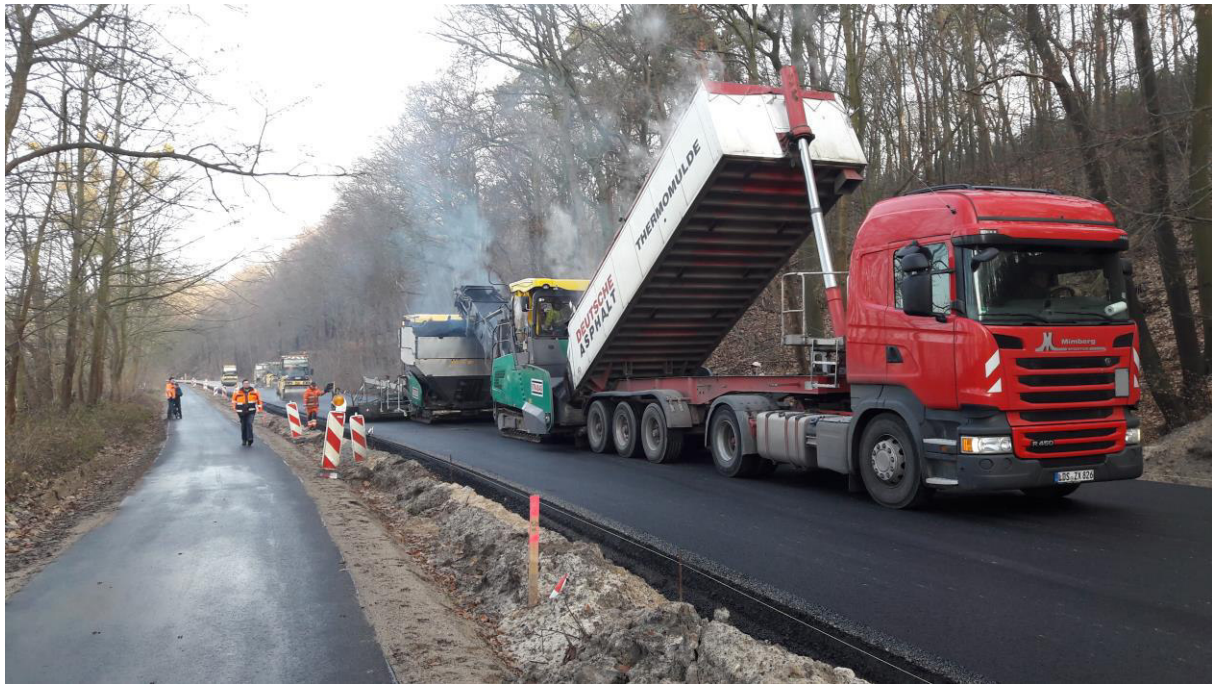
Abb. 12: Sanierung der Templiner Straße – ein gemeinsames Projekt der LHP und der Gemeinde Schwielowsee. Foto: LHP / Verkehrsanlagen
