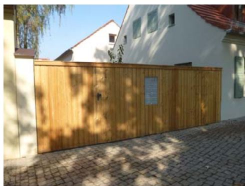
Briefkastenanlage, im Holzzaun integriert
