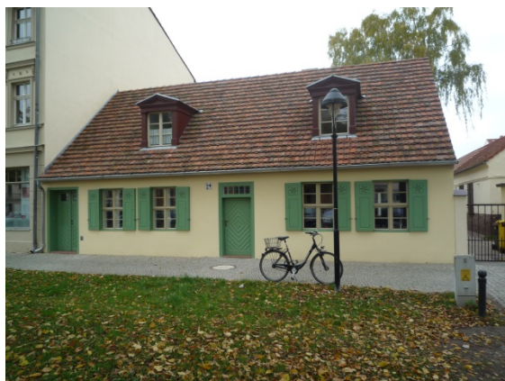
Beispiel für ein denkmalgerecht saniertes Kolonistenhaus
