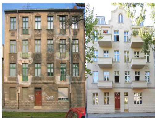
Vorher Nachher Rekonstruierte Fassadenelemente (Balkonanlagen und Frontspieß)
