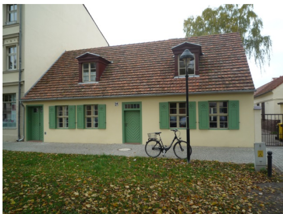
Beispiel für ein denkmalgerecht saniertes Kolonistenhaus
