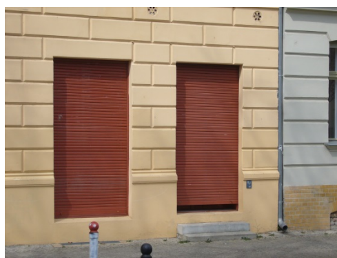
Beispiel für Rollläden an einem Gründerzeitgebäude
