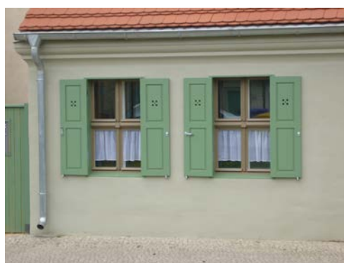
Klappläden mit Leibungskästen an einem Kolonistenhaus
