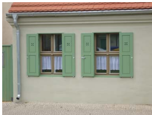
Klappläden mit Leibungskästen an einem Kolonistenhaus
