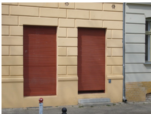
Beispiel für Rollläden an einem Gründerzeitgebäude
