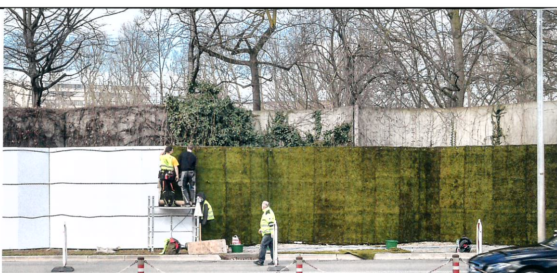
Die Umweltbehörde hatte 2017 an einem Stuttgarter Belastungshotspot eine Mooswand von 100 m Länge und einer Höhe von 3 m in Betrieb genommen. Foto: Landeshauptstadt Stuttgart
