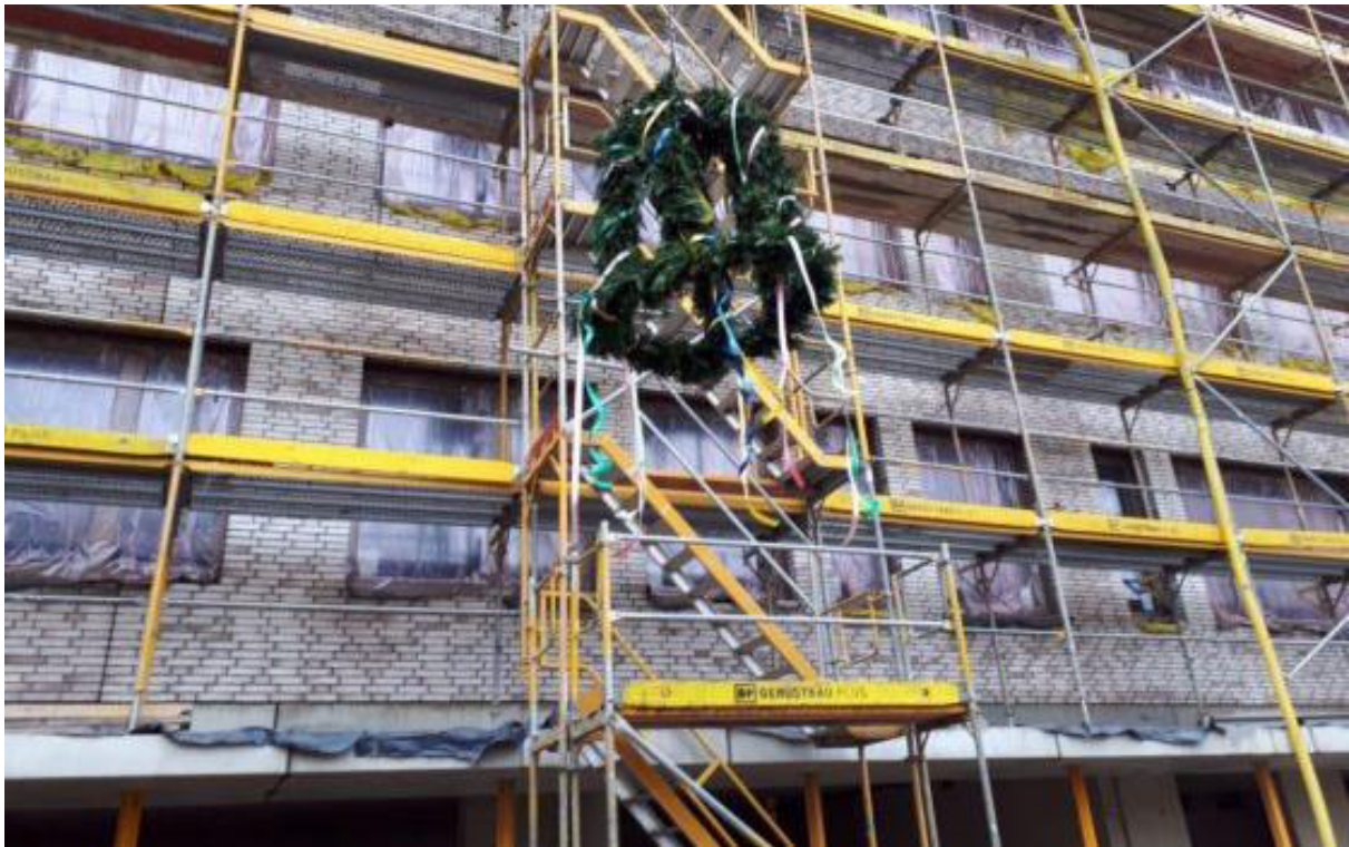
Abb. 15: Campus Gagarinstraße – Richtfest Schulneubau Montessori-Schule am 23. Januar 2018 (Foto: KIS / Markus Klier)
