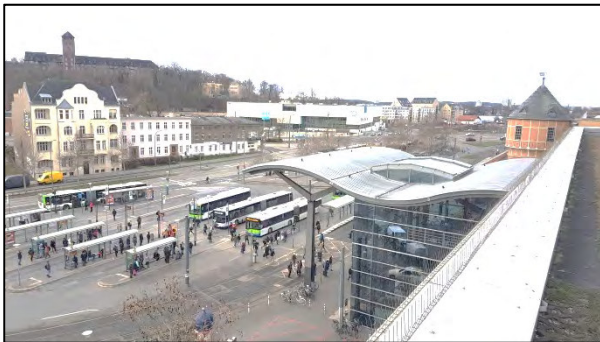
Abbildung 11: Bahnhofsvorplatz und Heinrich-Mann-Allee (Blickrichtung Südwesten)
