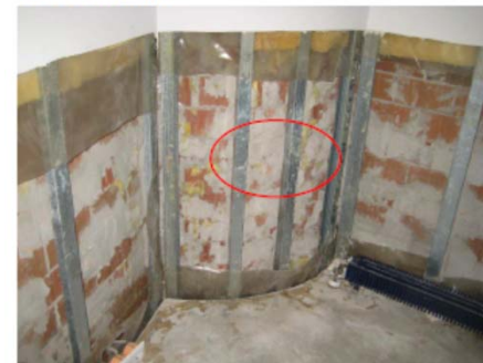
Befestigung einzelner Steine an Profilen - direkt mit Schrauben / oder Laschen > keine nachweisbare Befestigung der Vormauerschale
