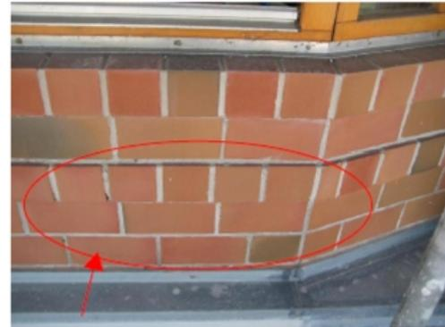
Vormauerschale mit Fehlstellen, losen Fugen, Ausbruchstellen
