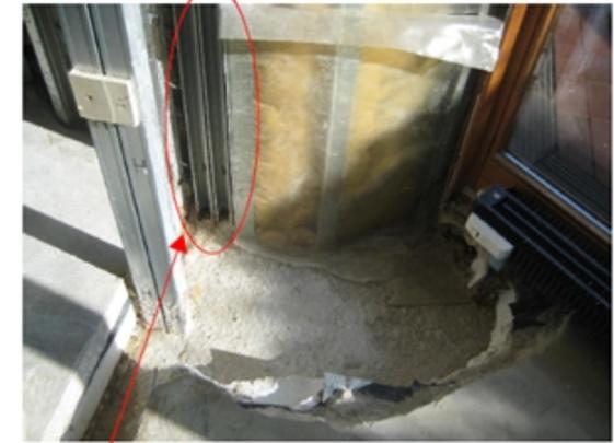
Anschluss der Doppelständer zu Vormauerschale z.T. mit breiter offener Fuge, keine durchgehende Dampfsperre
