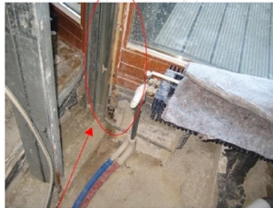
Wohnungstrennwände wurden zum Teil im Bereich der Außenwand an die Holzkonstruktion der Fensterfront angeschlossen. Dieser Anschluss entspricht nicht der geforderten Bauart für Wohnungstrennwände mit einem Feuerwiderstand von F90
