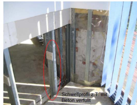
Bei der Herstellung der mit Doppelständern ausgefüllten Wohnungstrennwände wurden die beiden Ständer direkt nebeneinander gestellt und mit einem Gipskartonstreifen verbunden. Durch diese Bauweise ist der erforderliche Schallschutz nicht gegeben.
