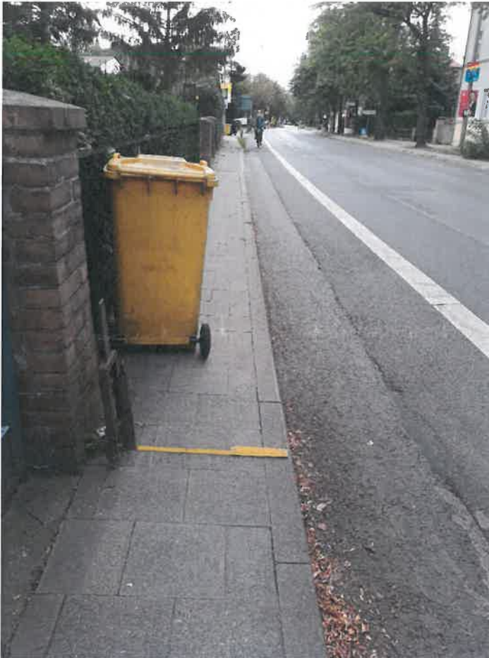
Abbildung 5: Fußweg Großbeerenstraße im Abschnitt Gagarinstraße – Neuendorfer Straße (Durchgangsbreite von nur 60 cm bei einer Verkehrsgeschwindigkeit von 50 km/h!)
