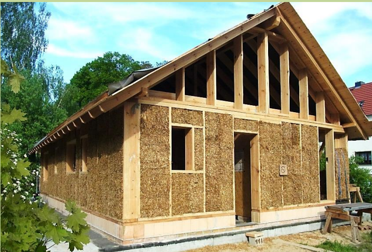
Haus in Strohballenbauweise Bad Belzig
