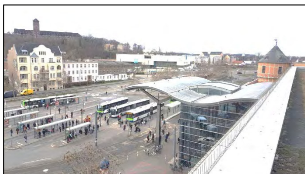
Abbildung 11: Bahnhofsvorplatz und Heinrich-Mann-Allee (Blickrichtung Südwesten)
