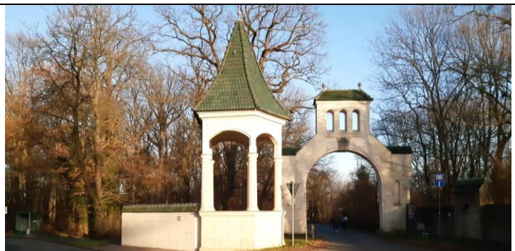
Die linke Seite des Potsdamer Tor-Ensembles ist fertig: Noch vor Jahresende ist das letzte Mauerstück gestrichen worden. Dank an Fa. Roland Schulze! Jetzt steht noch die Sanierung der Mauer rechts an.
