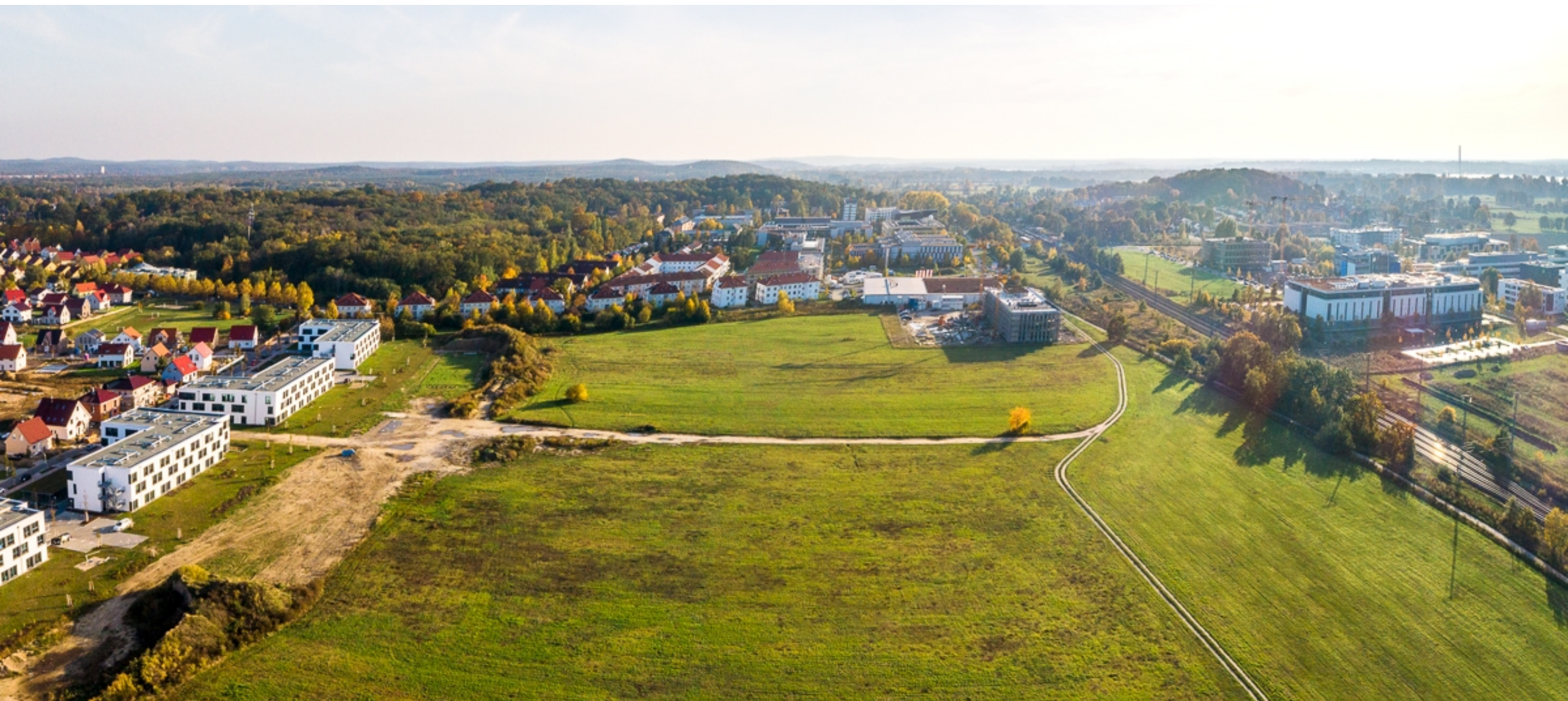
Blick über den Technology Campus von Norden, Oktober 2019, © Benjamin Maltry
