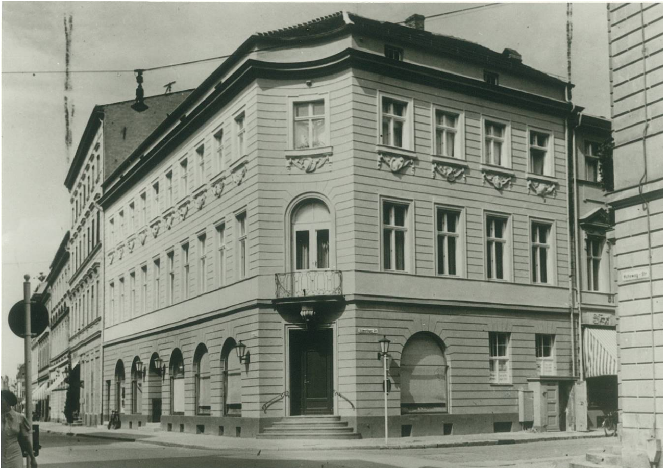
Hohewegstraße 3, Zustand nach Rückbau 1936, Aufnahme: BLDAM, Fotosammlung (ohne Nr.), 1938
