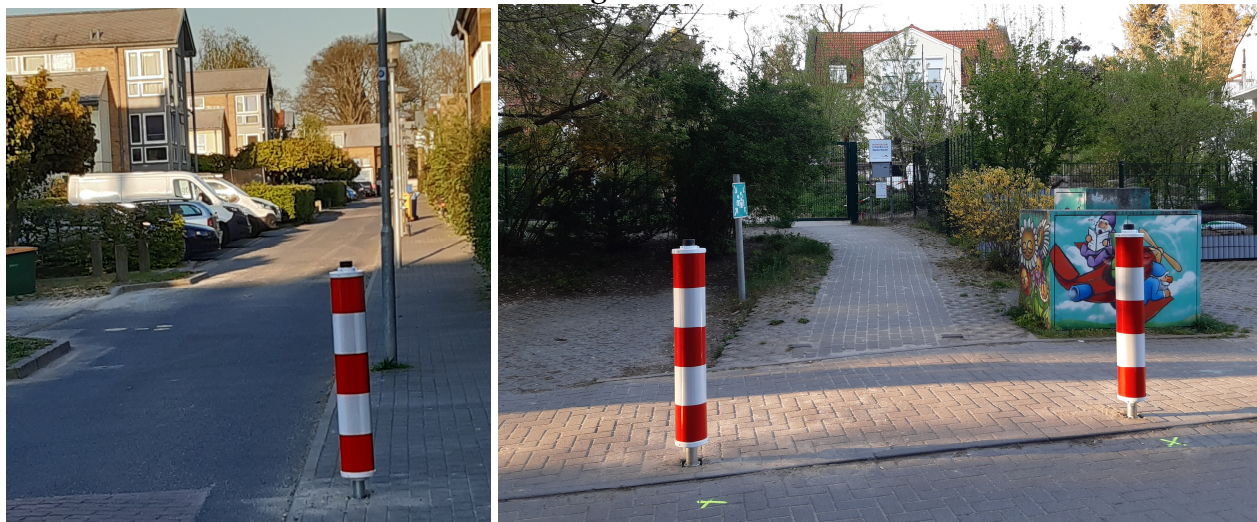
Links: Gehwegsicherung An der Kirche, rechts: Gehwegsicherung An der Sporthalle
