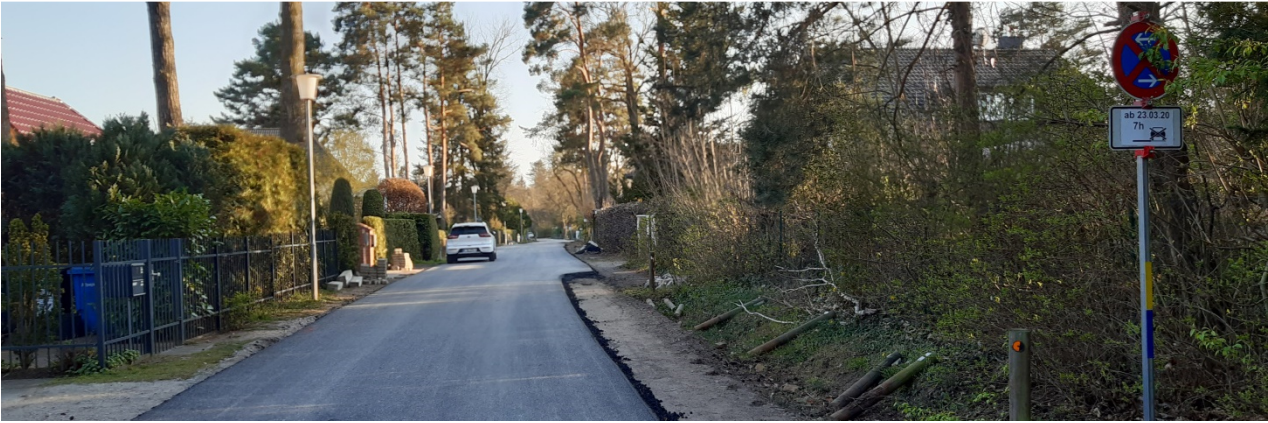
Wenige Tage vor Ostern: Erneuerung der Tristanstraße
