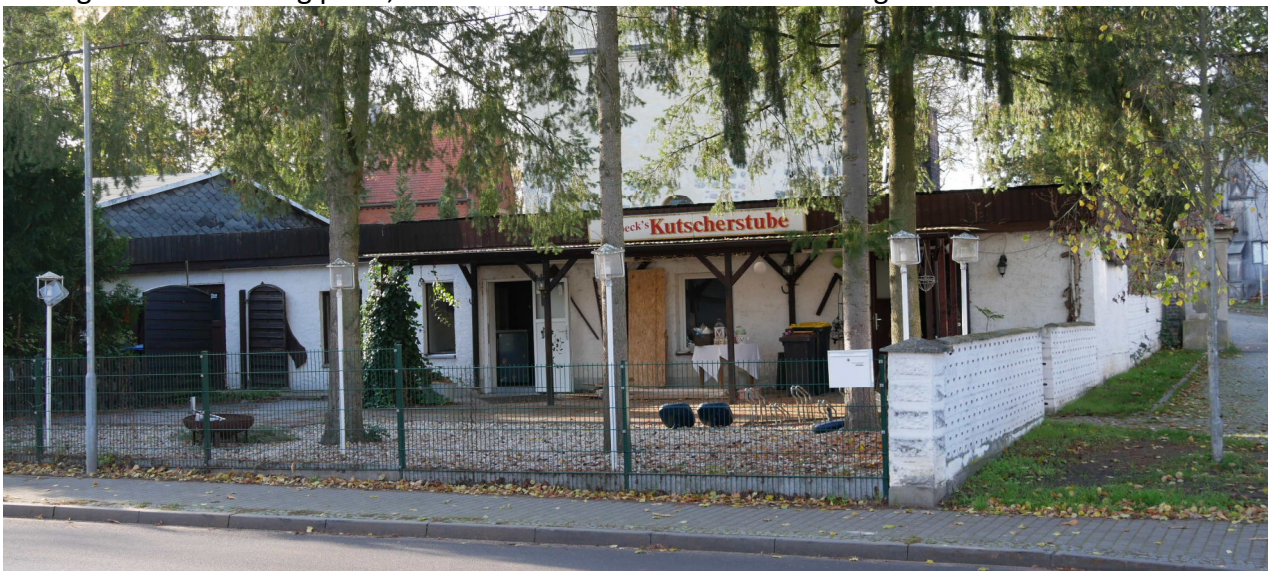
Vor der Kirche: die Kutscherstube. Nach dem Abriss der Bauten entsteht hier eine öffentliche Grünfläche.
