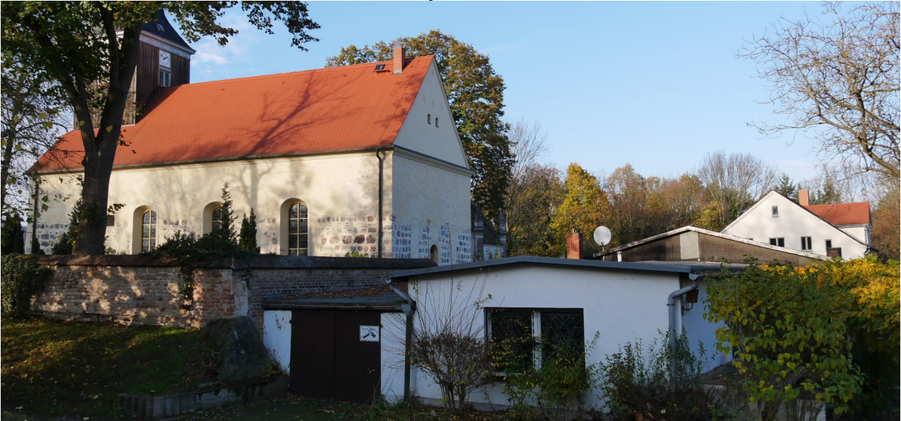
Im nächsten Jahr hat man hier einen freien Blick entlang der Friedhofsmauer hin zum Pfarrhaus.
