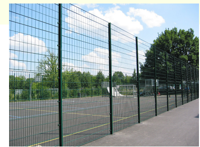
Ballfangzaun 4,0 m hoch, Oberfläche verzinkt
