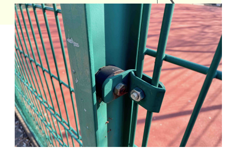
Schalldämmung mittels Gummipuffer
