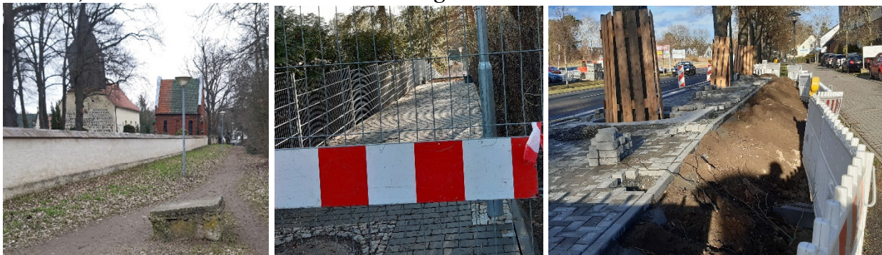
Links: Der Fußweg an der Friedhofsmauer hat Stolperfallen und wird instandgesetzt. Mitte: Der Verbindungsweg vom Anger zum Sportplatz nimmt Gestalt an. Die Bauarbeiten dauern aber noch einige Wochen. Rechts: Bushaltestelle Theodor-Fontane-Straße. Ein Problem ist die fehlende öffentliche Widmung des Gehwegs neben der Haltestelle.
