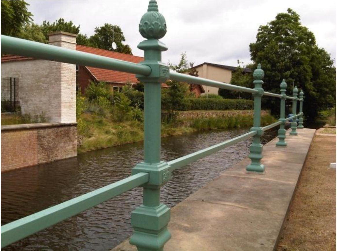
1 Situation am freigelegten Kanal 2013
