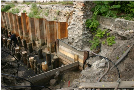
Arbeiten zwischen den alten und neuen Pfählen unter dem Torfeiler
