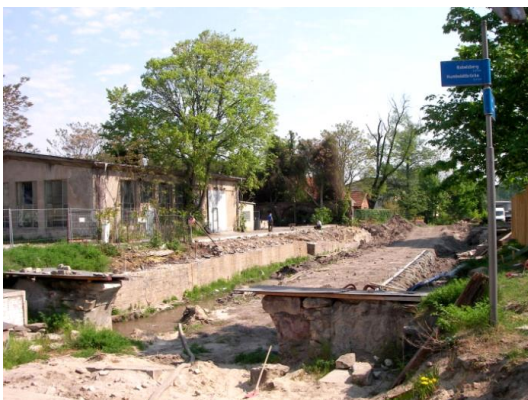
39 Freigelegte Brückenbögen der Kellertorbrücke
