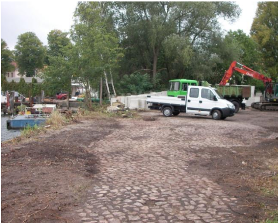
41 Pflasterungen auf dem ehemaligen Hafengrundstück vor der Uferabsenkung
