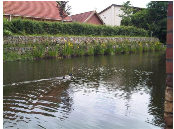
58 Neu hergestelltes Nordufer vor der Stadtmauer
