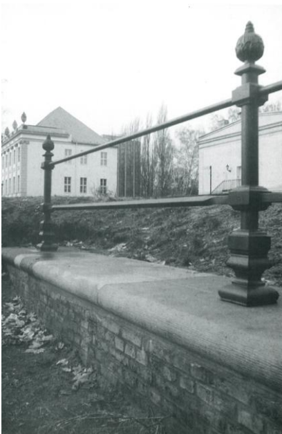
13 Erste Freilegung 1991 mit nachgegossenen Geländerpfosten,
