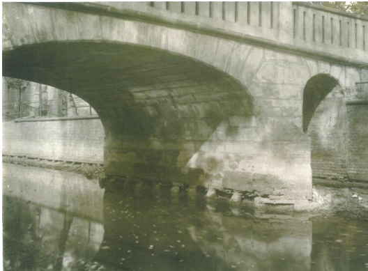
38 Nördlicher Stropfpeiler der Kellertorbrücke 1927 bei Niedrigwasser. Die gesamte Holzgründung ist zu erkennen
