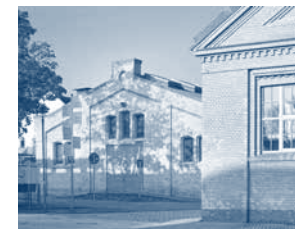
Reithallen A und B, 2017
