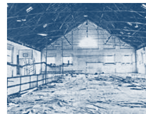
Reithalle A vor Sanierung, um 1990
