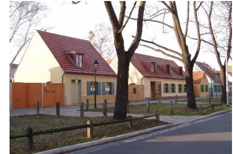
Weberhäuser in der Karl-Gruhl-Straße vor / nach Sanierung
