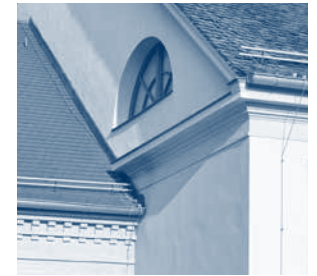
↑↑ Kammergebäude mit aufgestocktem Dach, 2018
