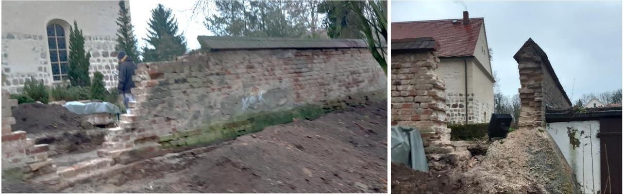
*Während die Bauten an der Dorfstraße abgerissen werden, wird bereits die Friedhofsmauer restauriert. Teile müssen abgetragen und wiedererrichtet werden. Aus einem Mauerstück wurde kurz zuvor ein Granatsplitter aus dem Zweiten Weltkrieg herausgezogen.*
