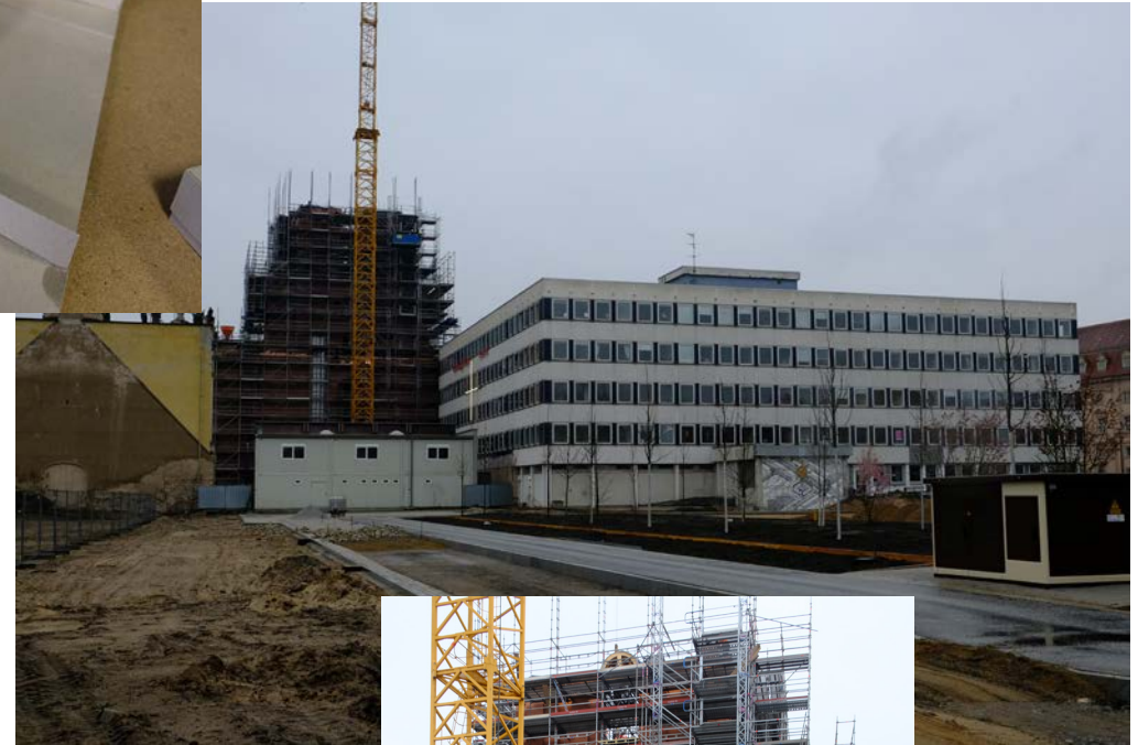
↑ Abb. 8: Blick auf Turmbau- stelle und Rechenzentrum.
