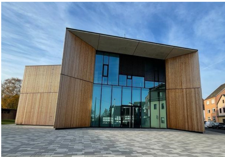
Abbildung 5 - Außenansicht Gemeindezentrum Troisdorf, Foto: Schubert
