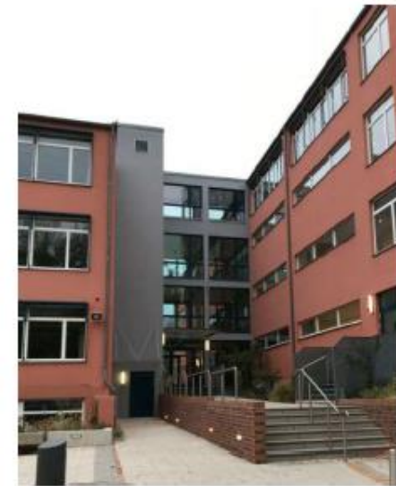
Foto Ostseite mit Aufzug
