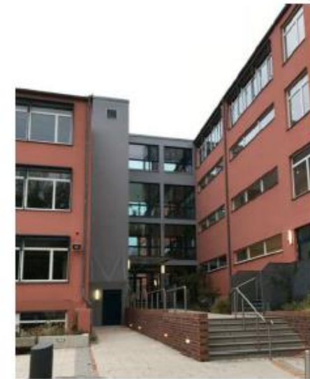
Foto Ostseite mit Aufzug
