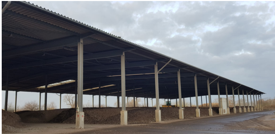
Bestand Nachrottehalle MBA → Kompostlager
