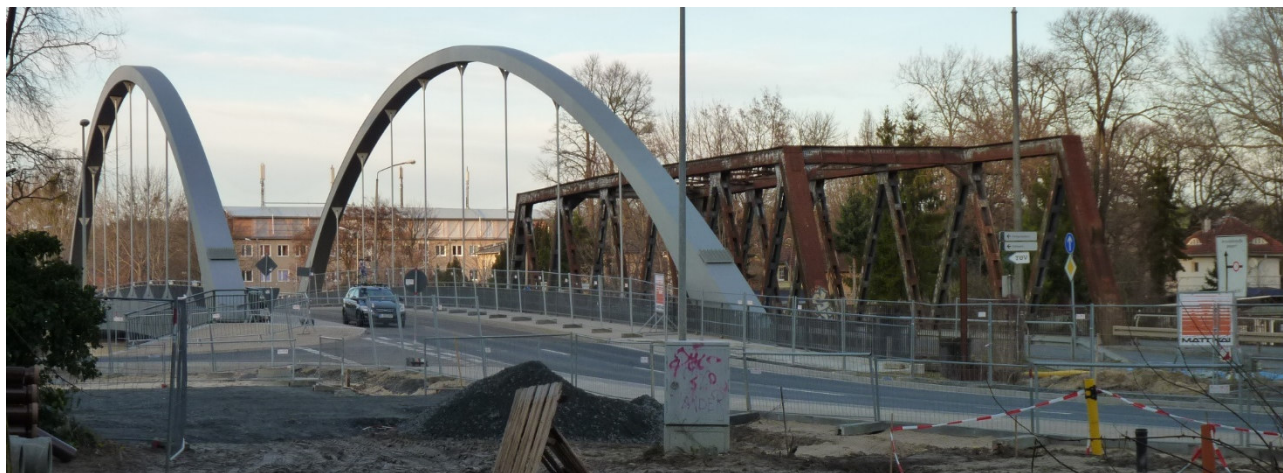
Der Weg nach Norden: Vor 10 Jahren wurde die Brücke nach Neu Fahrland neu gebaut. Beim Verhältnis der Stadt zu den „neuen“ Ortsteilen ist Brückenbau heute wichtiger denn je.
