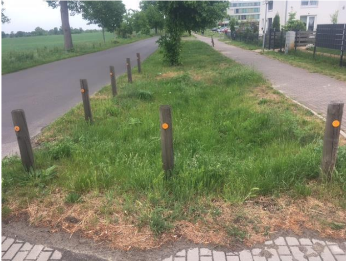
Holzpoller an Landstraße Golm sperren Versickerungsfläche im Straßenbegleitgrün
