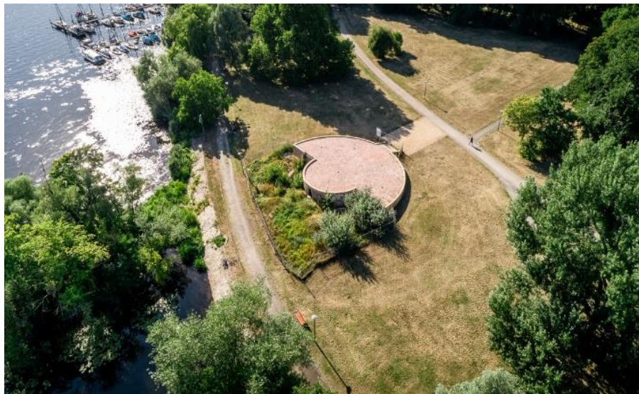
Bastion (i.d. Nähe vom Schillerplatz) (Ziel 2023)
