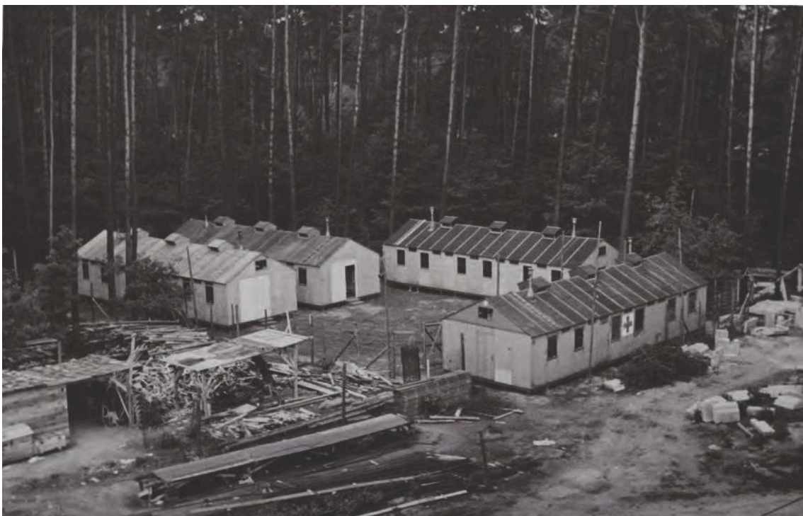
Das Zwangsarbeiterlager des DRK-Präsidiums befand sich im Wald westlich der Baustelle. Die Baracken waren mit dem Emblem des Roten Kreuzes gekennzeichnet, 1940 .
