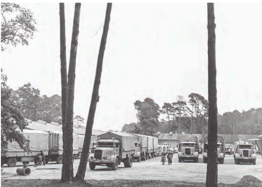
Für das mobile Bereitschaftslazarett des DRK wurde im Hauptlager in Potsdam-Babelsberg ein Garagenkomplex errichtet. Davor war das Lazarett in Güterfelde stationiert, 1940.
