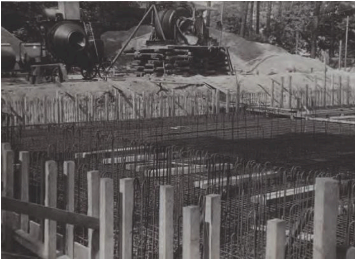
Bau eines Luftschutzbunkers auf dem Gelände des DRK-Hauptlagers durch KZ-Häftlinge, 1944.
