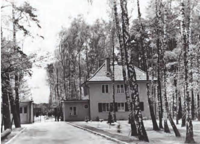
Die Wache am Eingang des DRK-Geländes, die Zufahrt erfolgte über die Stahnsdorfer Straße, um 1940.
