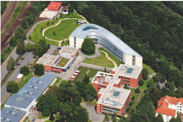
Luftbildaufnahme des HPI Campus I, 2011.
