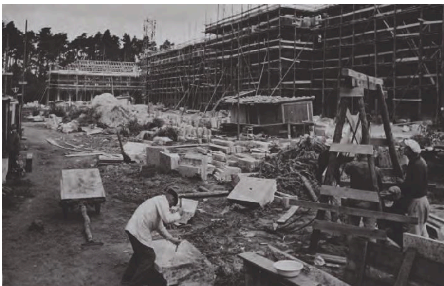
Baustelle des DRK-Präsidiums kurz vor dem Richtfest, 1940.
