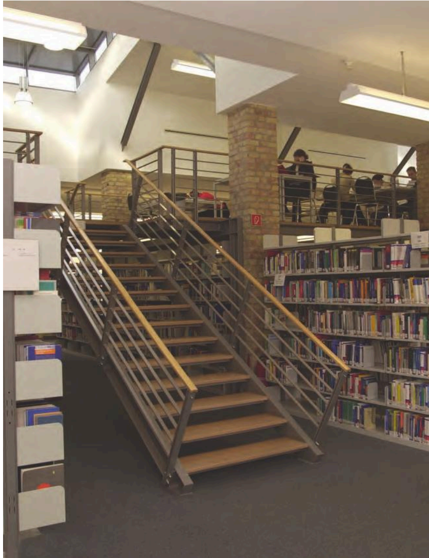
Aufgang zum Zwischengeschoss der Bibliothek, 2002.
