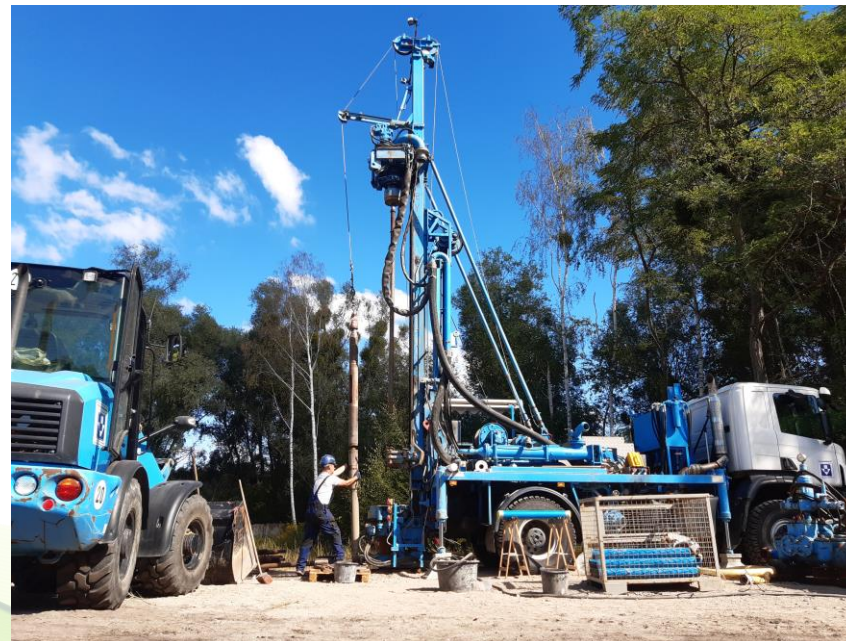
Geothermie Probepbohrung | Foto: EWP Andreas Dietrich
