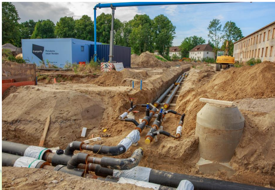
Neuerlegte FW-Leitung in Krampnitz || Foto: SWP
