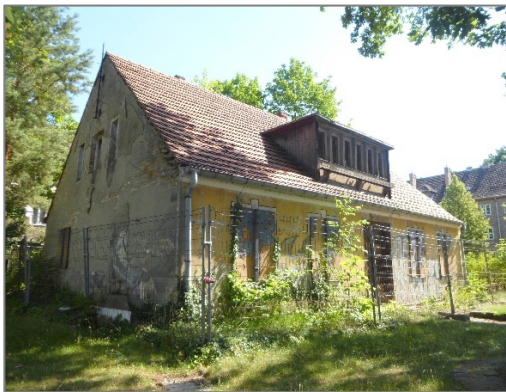
Heidehaus vor und nach der Sanierung
