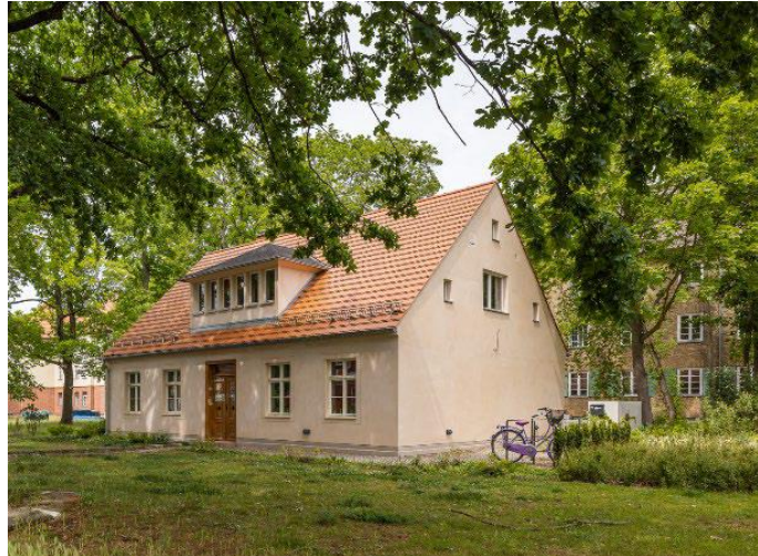
Heidehaus vor und nach der Sanierung Fotos: Setzpfandt
