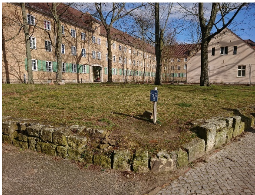
Grünfläche am Heidehaus vor und nach der Sanierung
