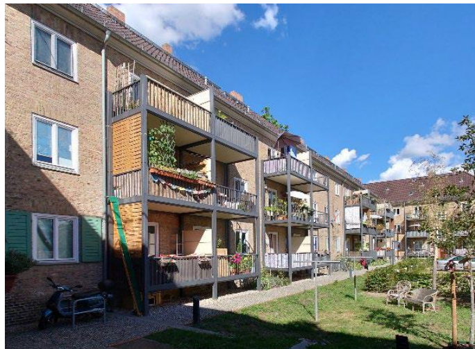
Heidesiedlung nach der Sanierung Fotos: Stadtkontor mbH
