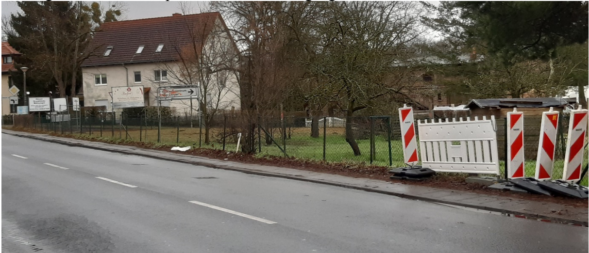
B 2-Ortsdurchfahrt vor der Glienicker Dorfstraße
