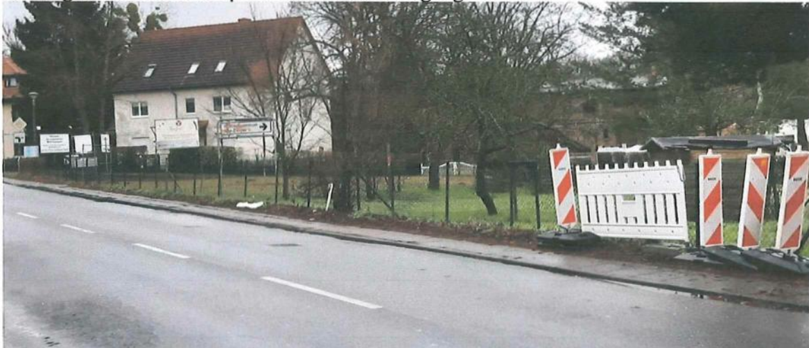
B 2-Ortsdurchfahrt vor der Glienicker Dorfstraße
