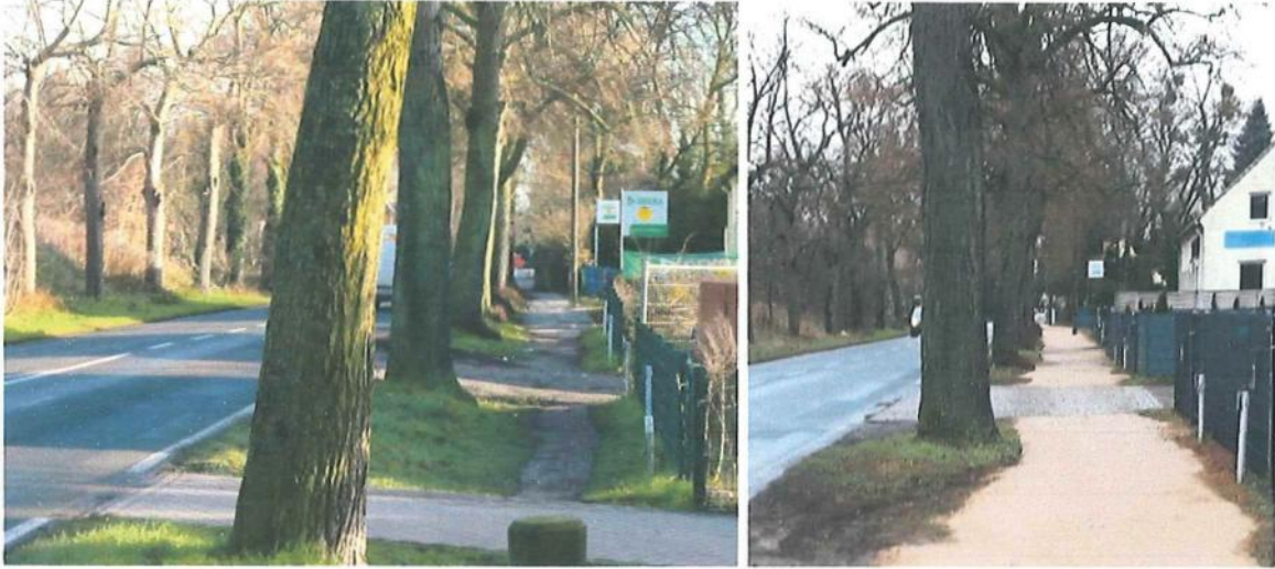
Gehweg vor und nach der provisorischen Befestigung
