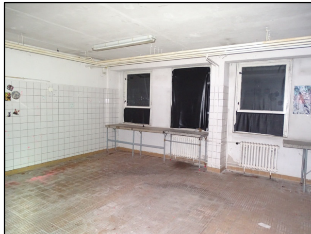
Abbildung 4: Kellerraum im Haus 1
