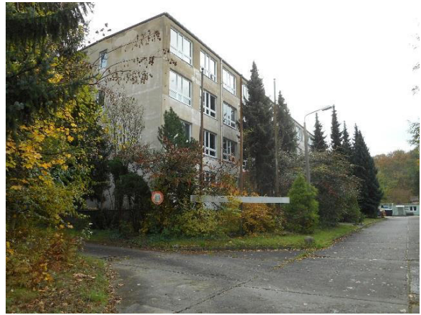
Abbildung 4: Bürogebäude auf Plangebiet
