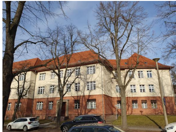
Abbildung 19: Wohnungsbau der 1920er Jahre
