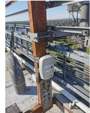
Quelle: EWP (LoRaWAN-Pilotprojekt)
