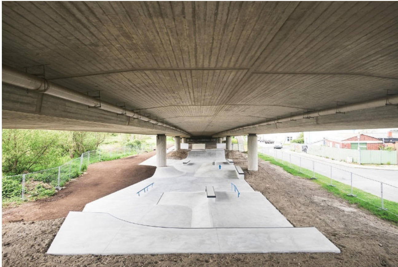
Emden: Larrelter Straße (K39)
