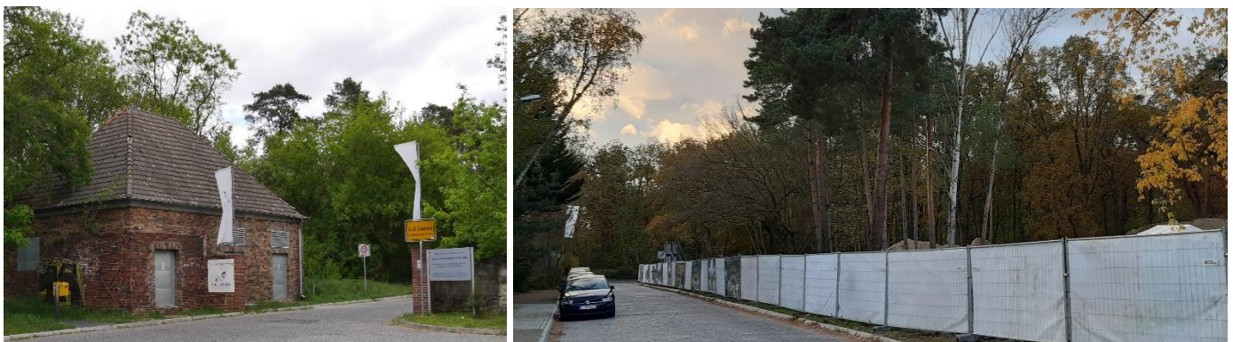
Links: das ehemalige Trafohaus, das inzwischen abgerissen wurde. Rechts: der Bauzaun heute, hinter dem das Multi-Kiosk-Café, der Kinderspielplatz und zwei Wohnhäuser gebaut werden. Wo früher das Trafohäuschen stand, entsteht das Café.
