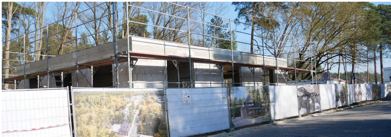
Gegenüber dem Neuen Atelierhaus Panzerhalle wächst der Cafébau am Eingang zur Waldsiedlung in die Höhe. Früher stand hier das Traföhäuschen.
