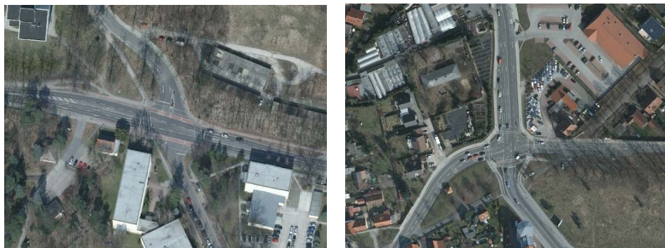
Abb. 33 Für Kreisverkehre geeignete Knotenpunkte (links: Großbeerstraße/ Jagdhausstraße, rechts: Zum Kirchsteigfeld/ Sternstraße)
