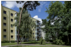
Sanierter Plattenbau Am Stern
