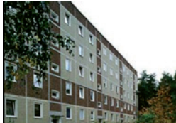
Unsaniertes Plattenbau Waldstadt II
