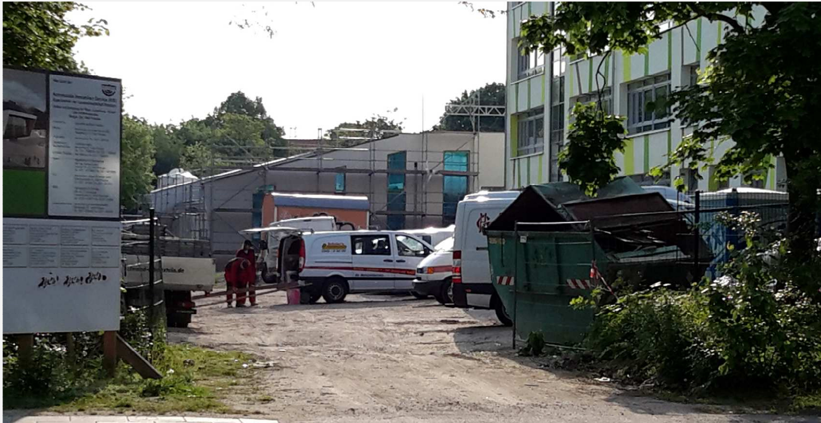
Gelände hinter saniertem Schulflügel (einschließlich Mensaneubau) © Sabine Volk (SHK), 18.05.2015
